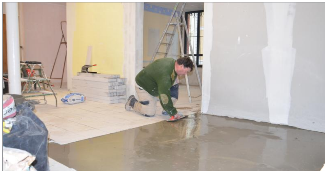
Au 56 rue de la Tannerie, vestiaire et vente de meubles vont se faire dans des locaux totalement rénovés et plus lumineux.
